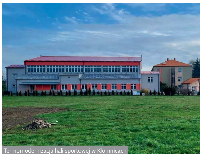
Termomodernizacja hali sportowej w Kłomnicach
