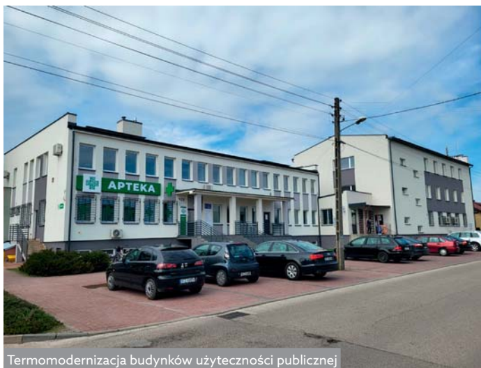
Termomodernizacja budynków użyteczności publicznej
