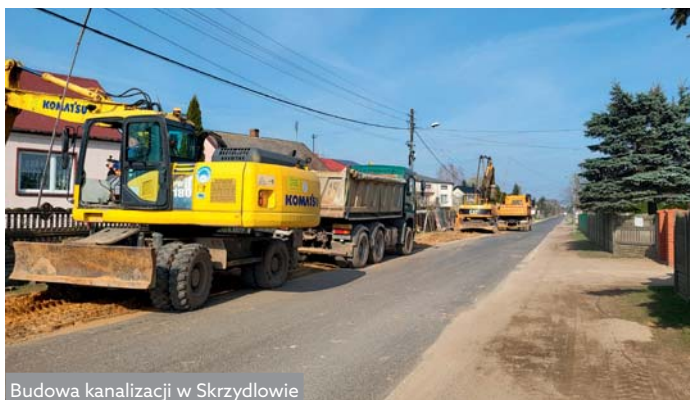
Budowa kanalizacji w Skrzydlowie
