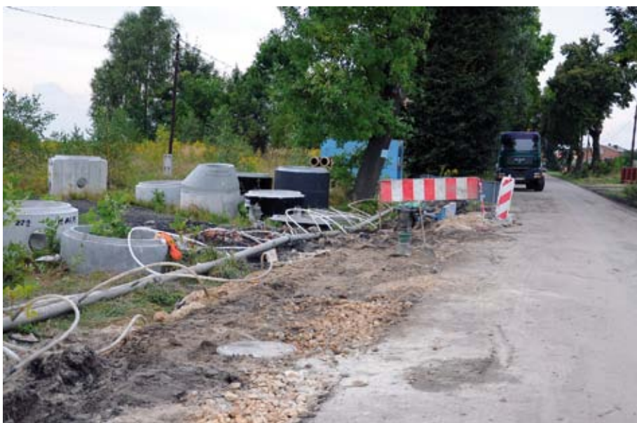
Budowa kanalizacji Adamów, Huby, Rzerzęczyce
