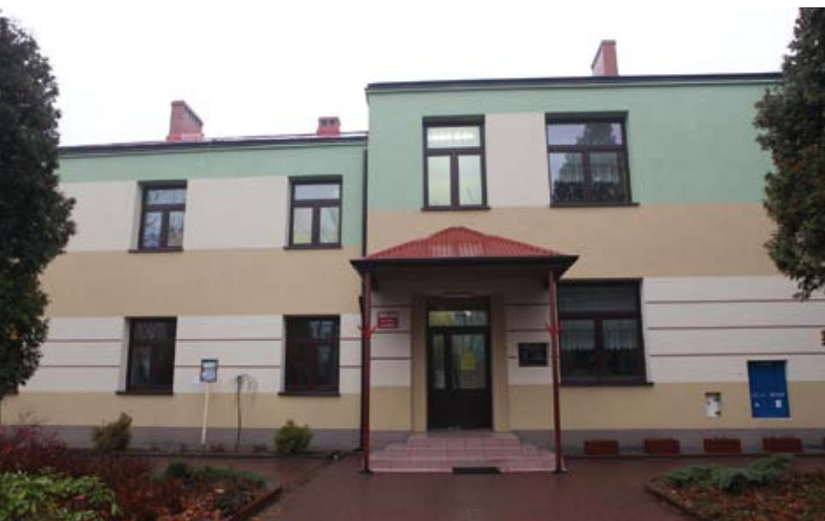
Nowa elewacja budynku szkoły w Garnku
