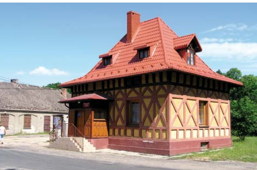
Odnowiony budynek biblioteki w Garnku
