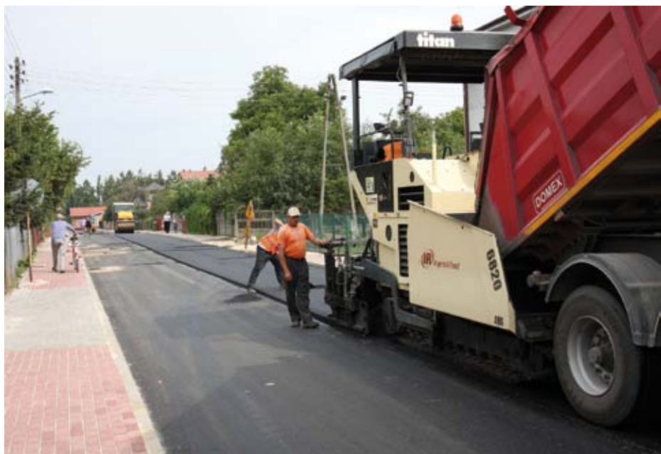
Wylewanie nowej nawierzchni na ulicy Strażackiej w Kłomnicach
